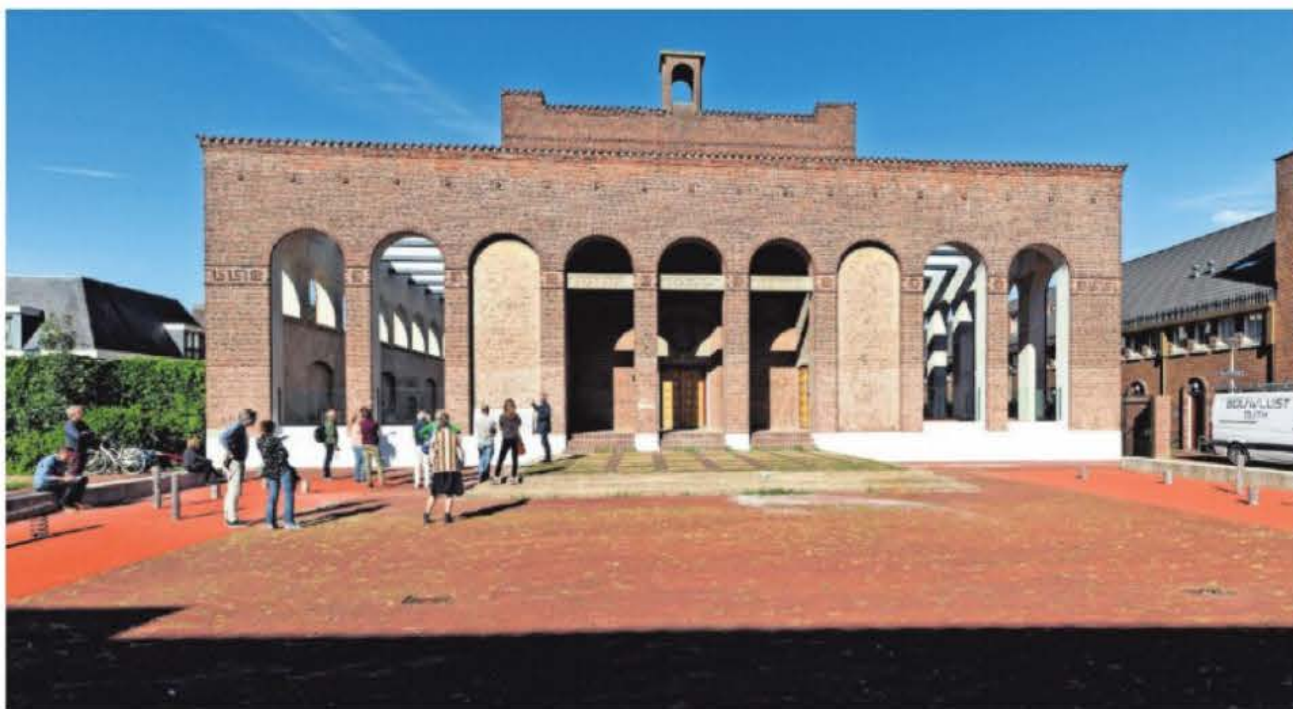
▲ In de voormalige kerk Onze Lieve Vrouw van het Allerheiligste Sacrament aan de Grovestinsstraat komen 26 woningen. Architect Mark Graafland (onder) is hartstikke trots op het project.
