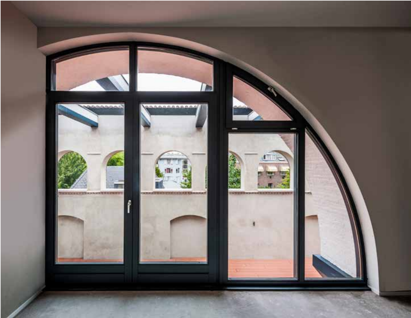
Vanuit de woningen is een gelaagd beeld ontstaan, waarbij constructie en omgeving samenkomen
